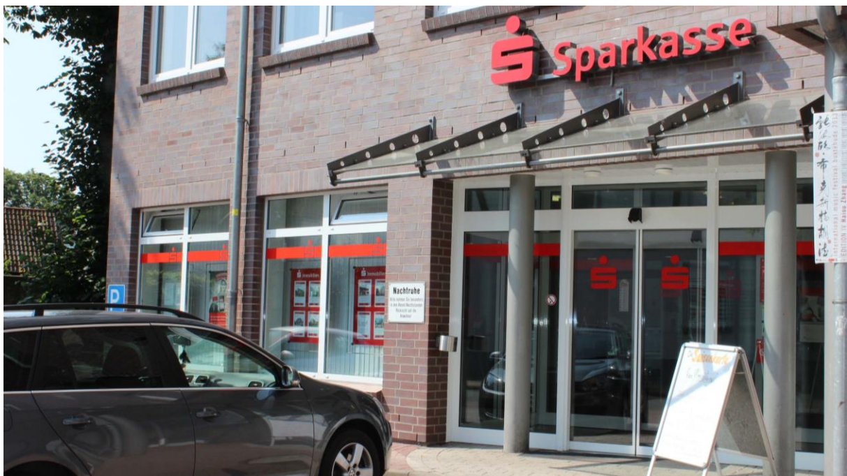
Das Beratungscenter der Sparkasse Harburg-Buxtehude in Buxtehude-Altkloster.
